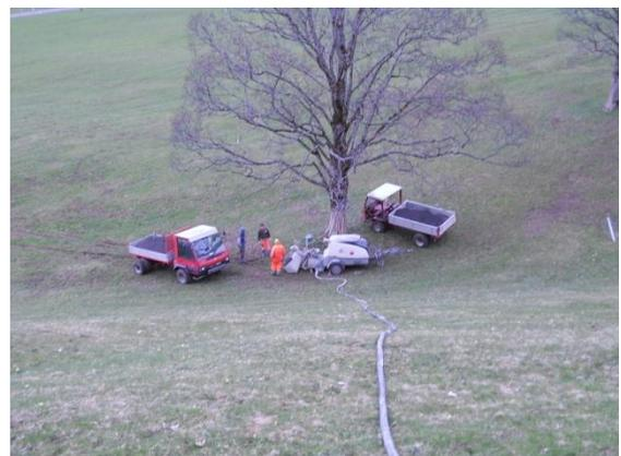
via Pumpe und Leitung wird der Sand nach oben befördert
